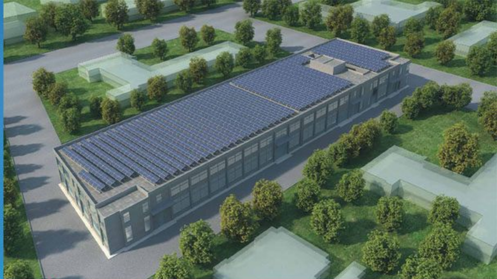
1 厂内光伏屋顶电站
